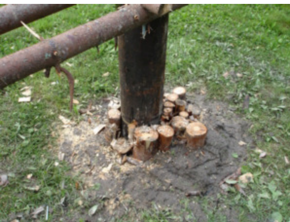
042_Stolpekarusell_Detalj_PlugginMidtstokk
